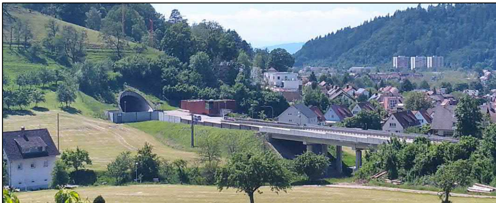
Abbildung 14 – Schallschutz an der B 294, Bereich Dettenbachstraße
