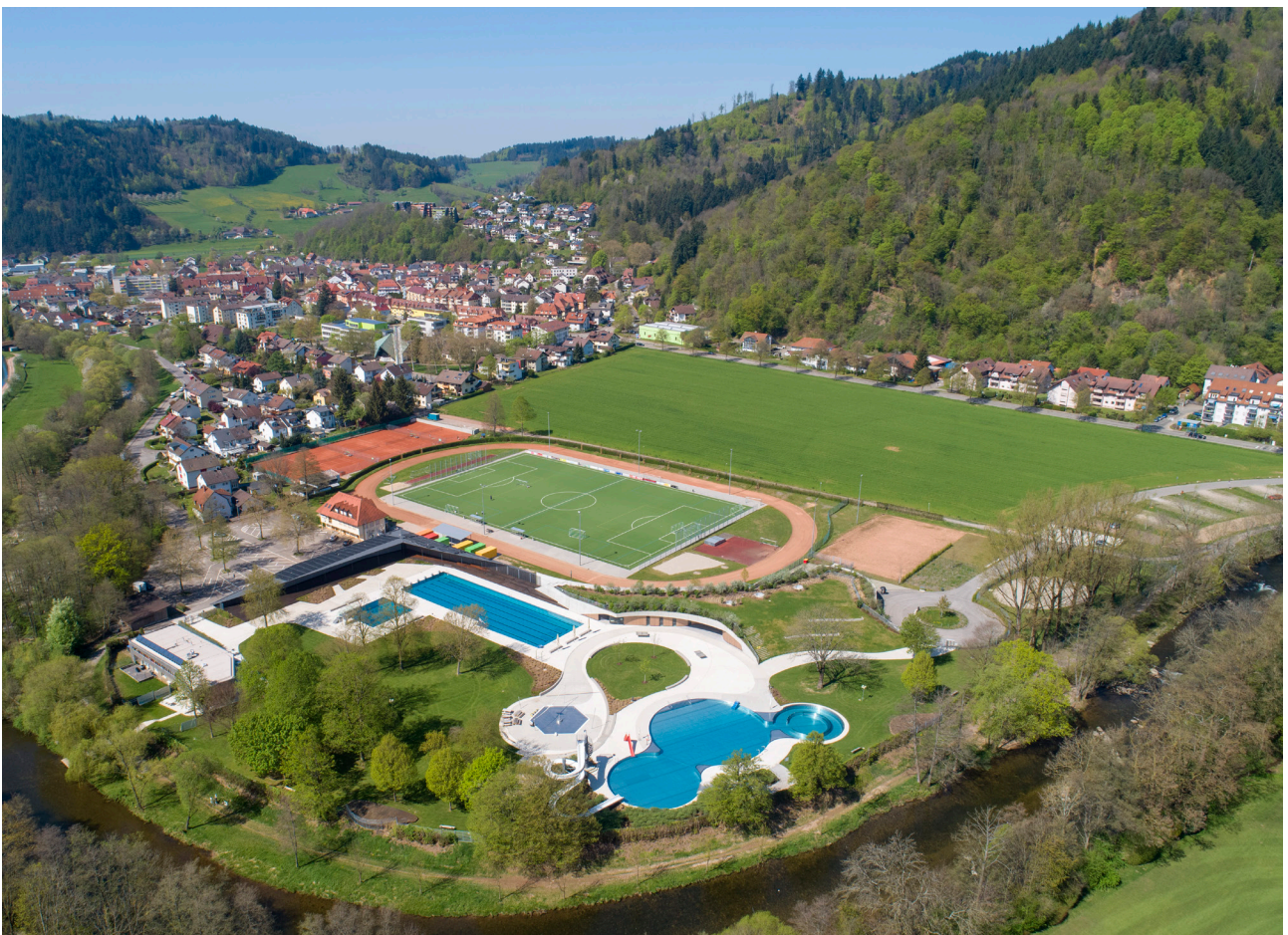
Drohnenaufnahme des Baugebiets „In der Elzschleife“
